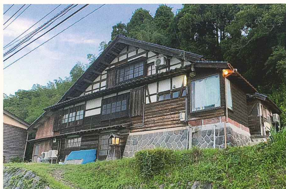
宿泊は、空き家を利用した「春蘭の里」別館で、穴水町の海沿いにあり建物被害は少なかったとのこと
