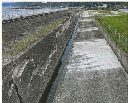
地震で破壊された能登町うみとさかなの科学館前の防波堤兼釣り場の状況
